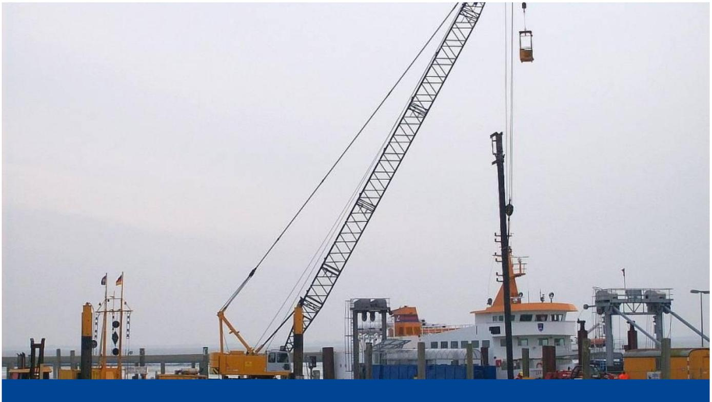
**Rückbau der vorhandenen Anlegebrücke und Erstellung einer neuen Brücke aus Stahlrohrpfählen mit einem Betonüberbau auf einer Fläche von ca. 1.300 qm.**
