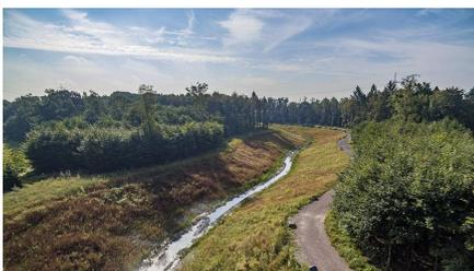
**Renaturierungsmaßnahme: Entflechtung der natürlichen Reinwasserzuflüsse, die in einer neuen Trasse im Freigefälle der Emscher zugeleitet werden mit dem Ziel der Reduzierung des Mischwassers in der Kanalisation und Hochwasserschutz für eine Kleingartenanlage.**
