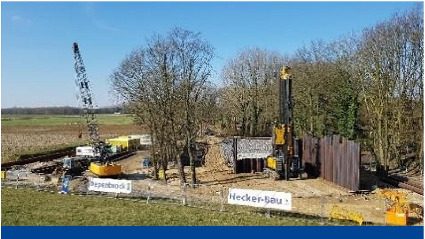
Im Zuge des Projektes wird das alte Auslaufbauwerk abgebrochen und ein neues Auslaufbauwerk, mit einer neuen Ablaufleitung hergestellt. Im Ablaufgraben wird ein verklammertes Schüttsteindeckwerk als Sicherung für Böschung und Sohle ergänzt. Die Baustelle befindet sich am Stadtrand von Greven, parallel zur Ems.
