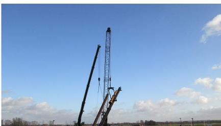
**Rammarbeiten zum Anschluss der Schrägpfähle an die Spundwand, sowie Herstellen und Einbauen von zwei Dalben**
