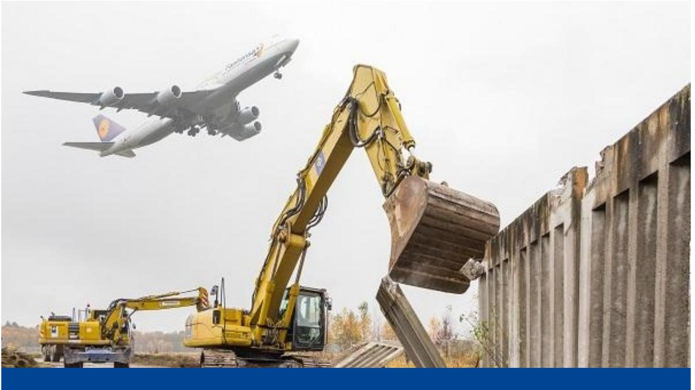
Komplexe Tiefbauarbeiten an der Startbahn West: Rückbau des alten Zauns, die Herstellung von Kabeltrassen, ca. 52 km Einzelrohre, die Errichtung von 250 Lichtmasten und ca. 100 Schachtbauwerken für Kabelleerrohranlagen. Zu den Leistungen gehört auch der Neubau von ca. 2.400 Einzelfundamenten der neuen Zaunanlage einschließlich 6,0 km Unterkriechschutz für Kleintiere aus Bordsteinen sowie Bodenprofilierungen
