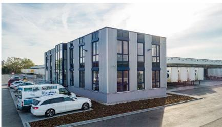
Schlüsselfertige Errichtung des Depots sowie aufwendige Tiefbaumaßnahmen mit Kanal-, Straßenbau sowie Asphaltbau. Es wurden 35.000 m<sup>3</sup> Gießereisande ausgebaut und anschließend lagenweise eingebaut und verdichtet.
