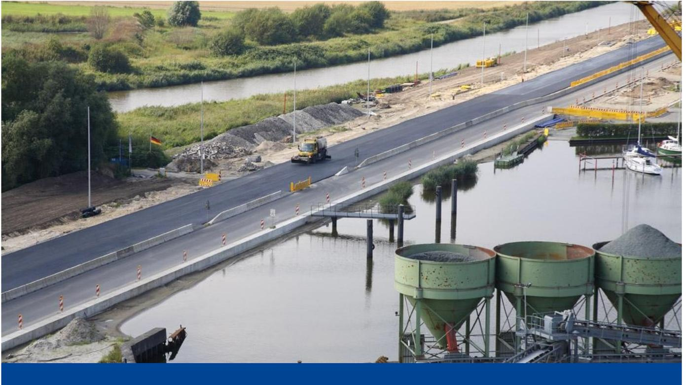
Herstellung einer Sicherungspundwand, Verbreiterung und Neubau der Straße "Am Luneort", Kanalbau, Kabel- & Rohrleitungsbau
