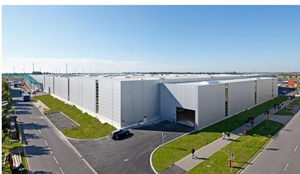
Sämtliche Tiefbauarbeiten sowie erweiterter Rohbau für die hochmoderne Logistikhalle auf einer Grundfläche von 46.000 m<sup>3</sup> und einer Höhe von 12 m einschließlich Anbauten für den Wareneingang, Warenausgang und Leergutumschlag.
