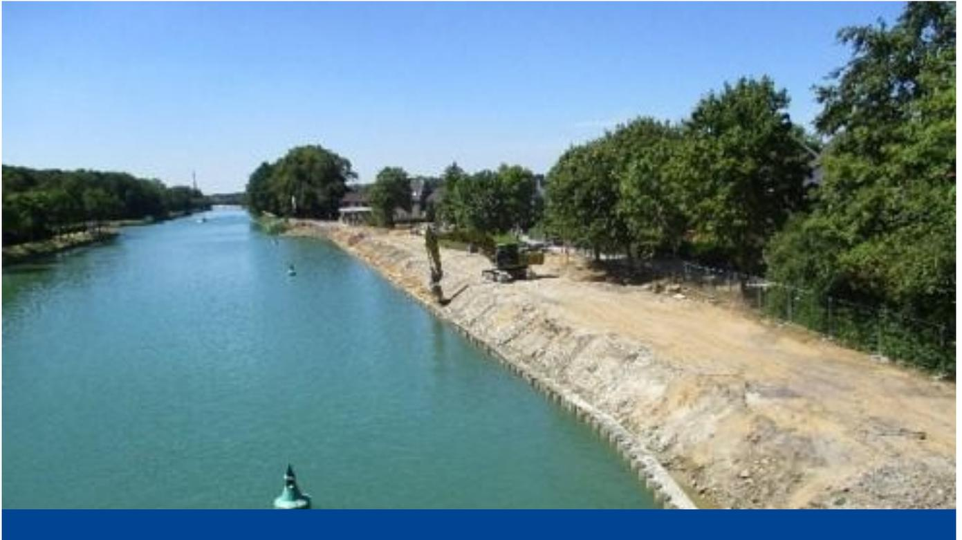
An einem ca. 230,00 m langen Abschnitt des Dortmund-Ems-Kanals wird eine bestehende Spundwand mit einem Stahlbetongurt ausgerüstet und erneut Rückverankert. Landseitig der Spundwand findet eine Oberflächenbefestigung mit Stahlbetonfertigteilen statt.
