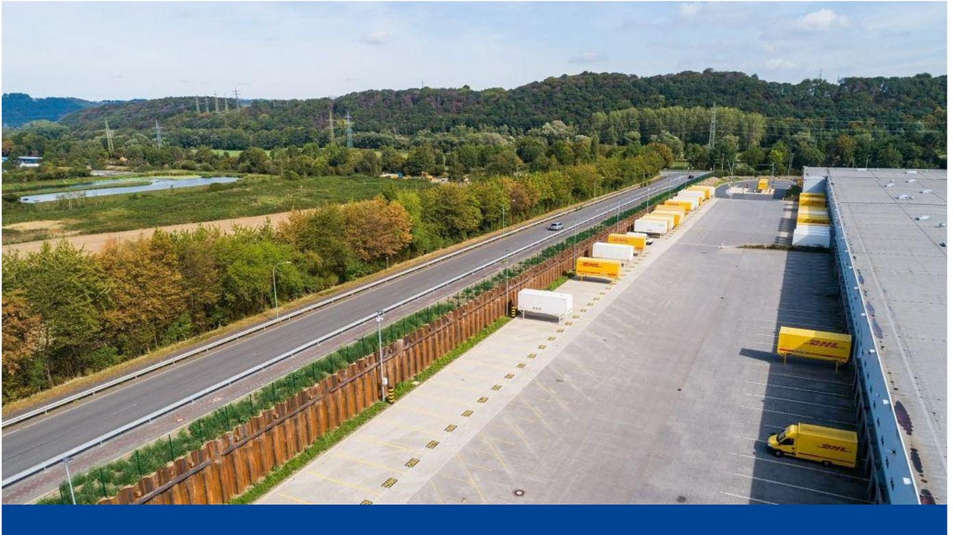
Um die Fläche des Postzentrums 58 in Hagen zu vergrößern wird die Böschung zwischen dem Postzentrum und der Federstraße auf einer Länge von 283,00 m durch einen steilen Geländesprung mit einer rückverankerten Spundwand ersetzt.
