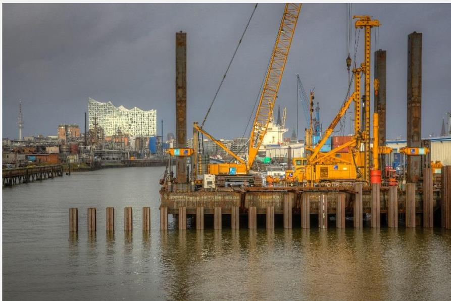
Die F+Z Baugesellschaft erhielt im Sommer 2017 den Auftrag für die Herstellung einer neuen Uferwand als senkrechten Abschluss der Hafenbeckenverfüllung des Steinwerder Hafens. Die Länge des Bauwerks beträgt von etwa 87 m. Der Auftrag umfasst neben den Anschlüssen an den Bestand den Bau von konstruktiven Entwässerungsbauwerken.
