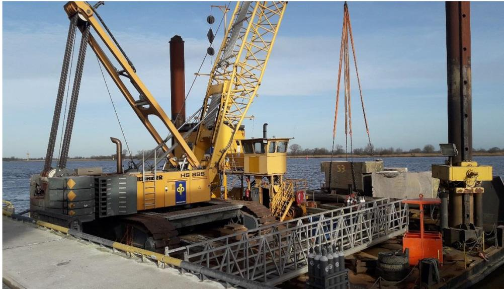
Sanierung von 14 Stck Pollerdalben, deren Gründung insbesondere in der Wasserwechselzone Querschnittsschwächungen infolge von Korrosion aufweisen.
